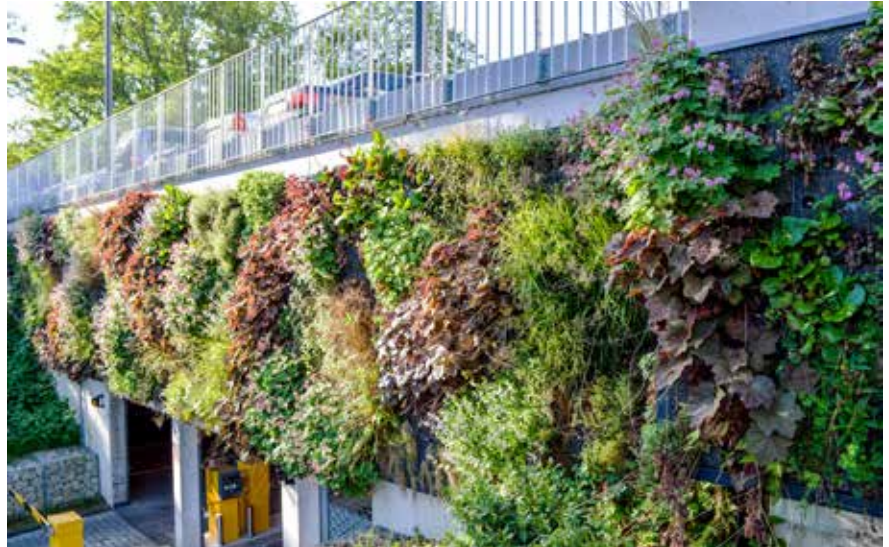
Abbildung rechts: Begrünung eines Parkhauses
