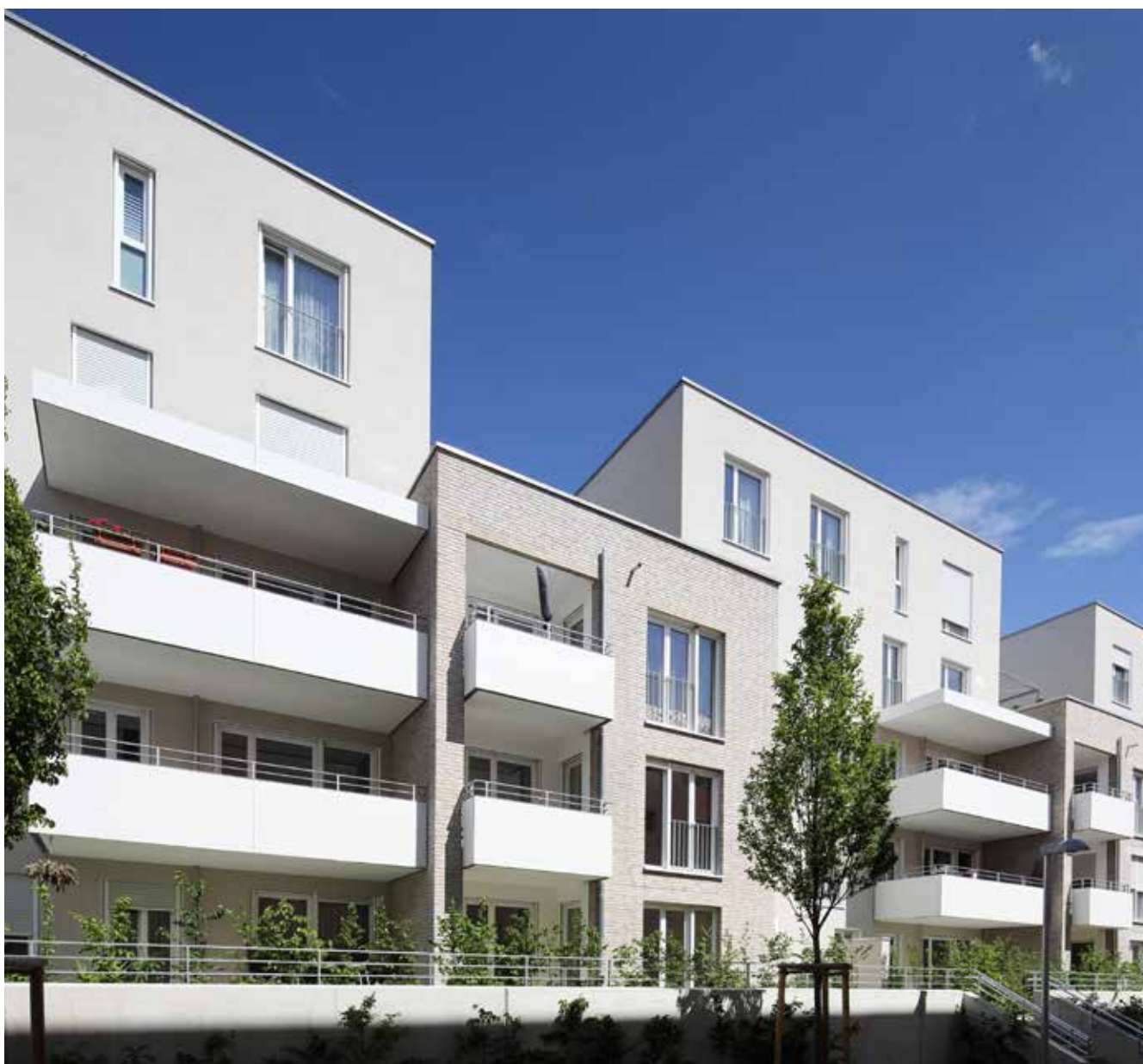
Abbildung oben: Mehrfamilienhaus in Ulm
