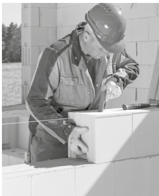
Griffhilfen erleichtern das Vermauern. Das Steingewicht soll 25 kg nicht überschreiten.
