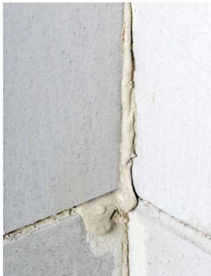
Bild 41 Vollfugiger Stumpfstoßanschluss mit Dünnbettmörtel vor dem Abstreichen
