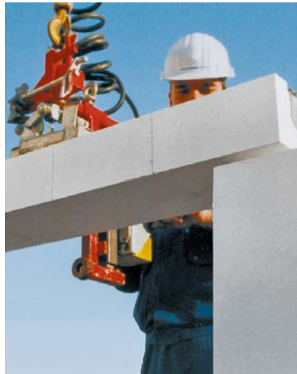
Bild 27 Vorgefertigte KS-Flachstürze zur schnellen und rationellen Öffnungsüberdeckung
