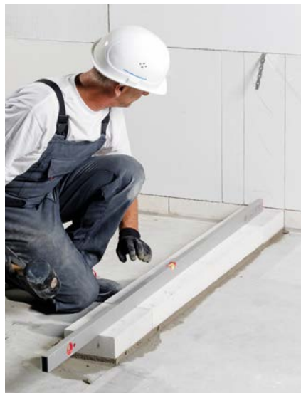
Bild 36 Kimmsteine in Längsrichtung ausrichten
