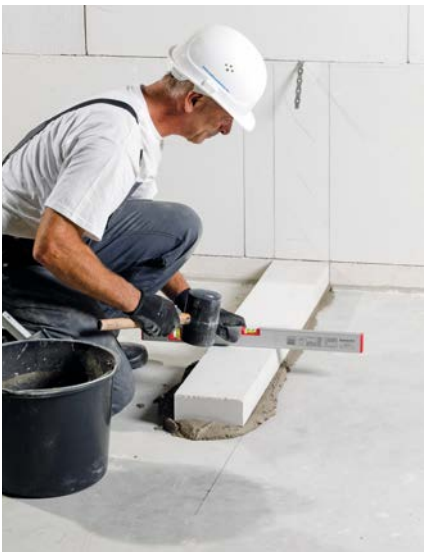
Bild 35 Kimmsteine in Querrichtung ausrichten
