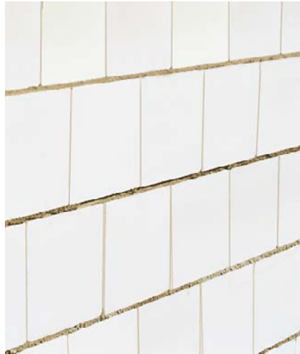
Bild 20 KS -R-Blocksteine für Normalmauermörtel
