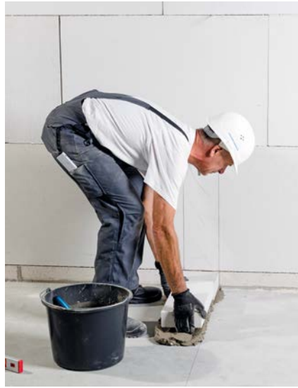
Bild 34 Kimmsteine ins Mörtelbett verlegen
