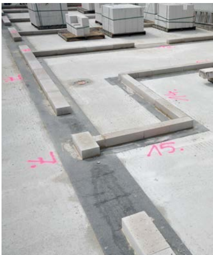
Bild 22 Anlegen der Kimmerschicht
