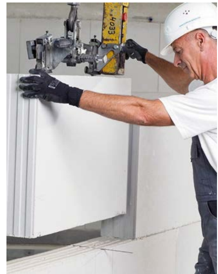
Bild 42 Versetzen der folgenden Elemente
