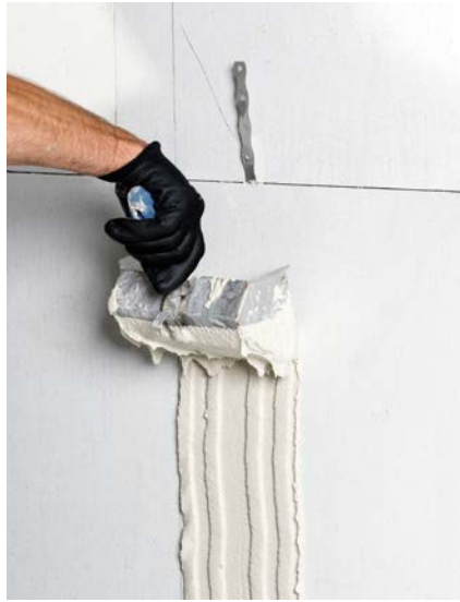
Bild 38 Mörtel für Anschlussfuge auftragen
