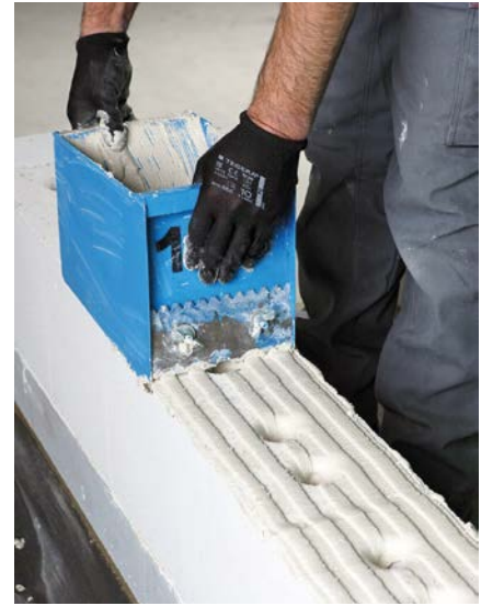
Bild 39 Auftragen des Mörtels für die Lagerfuge
