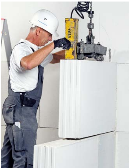
Bild 40 Versetzen eines XL-Elements
