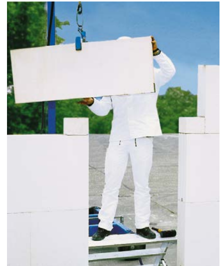
Bild 28 KS-Fertigteilstürze für großformatiges Mauerwerk
