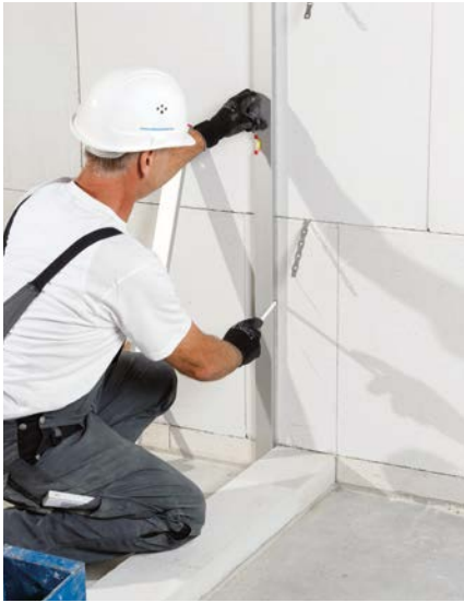
Bild 37 Anreißen der zu erstellenden Wand
