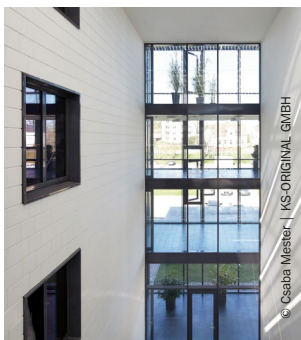
Fraunhofer Institut Karlsruhe Das KS-Sichtmauerwerk verleiht dem Gebäude ein modernes, sachliches Erscheinungsbild von hoher Qualität.
