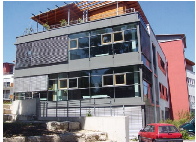
Abb. 2: Die Fassade wurde teils verputzt und farbig gestrichen. Teils ist sie mit einer Leichtmetallkonstruktion versehen, teils mit einer Holzverkleidung. Das farbige Wechselspiel aus Putz-, Leichtmetall- und Holzfassade verleiht der Anlage ein ganz besonderes Ambiente Fotos und Zeichnungen: KS-Quadro
