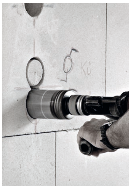
Abb. 5: Die Stelle, an der die Rohre wieder aus der Wand treten sollen, wird mit einem Kronenbohrer aufgebohrt und später als Steckdose oder Verteiler genutzt (Abb. links). Ein Großteil der Installationskanäle und Rohre ist in die KS-Quadro E-Wand verlegt. Auf diese Weise ist sehr viel Zeit und Geld gespart worden (Abb. rechts)
