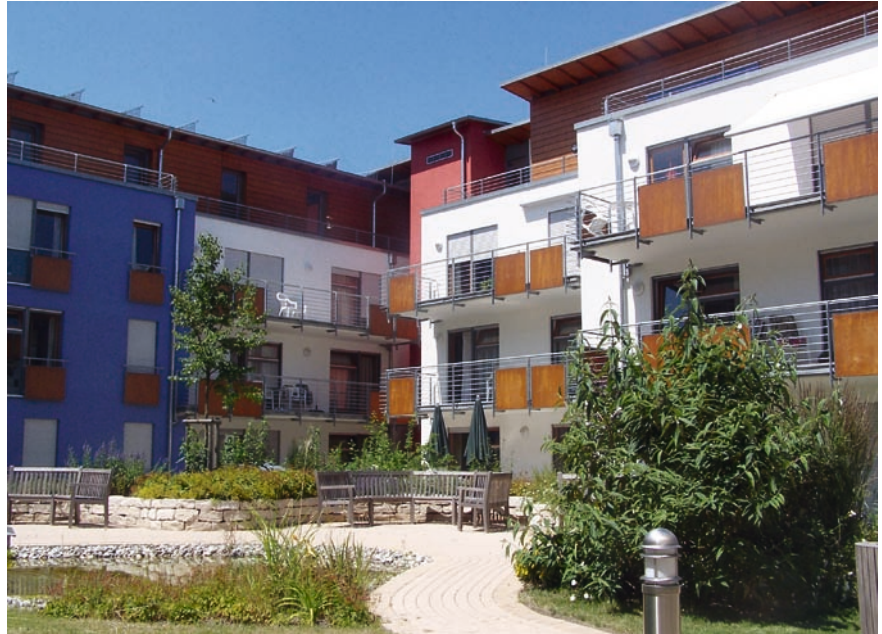
Abb. 3: Die drei unterschiedlich großen Baukörper gruppieren sich um einen zentralen Innenhof
