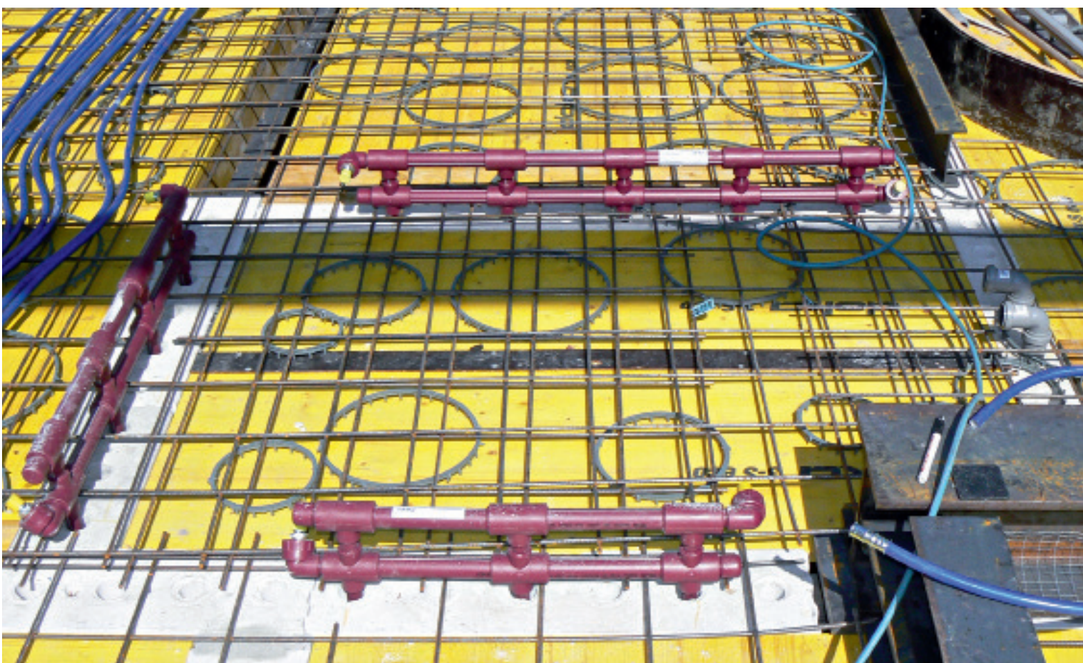
Die Temperierungsmodule werden nach einem vorgegebenen Installationsplan in die Kanäle des Mauerwerks gesteckt und mit Quarzsand verfüllt
