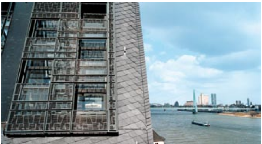
Metall-„Screens“ im Bereich der Schrägverglasung
