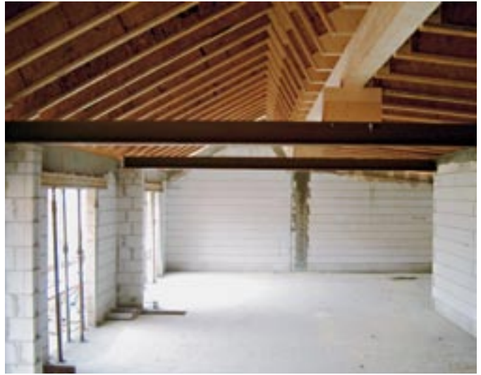
Dachgeschoss des Seminar- und Verwaltungsgebäudes im Rohbau
