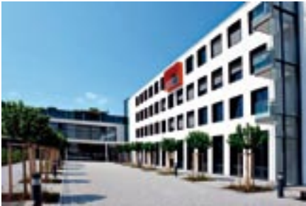
Ansicht Süd: Eingangsseite
