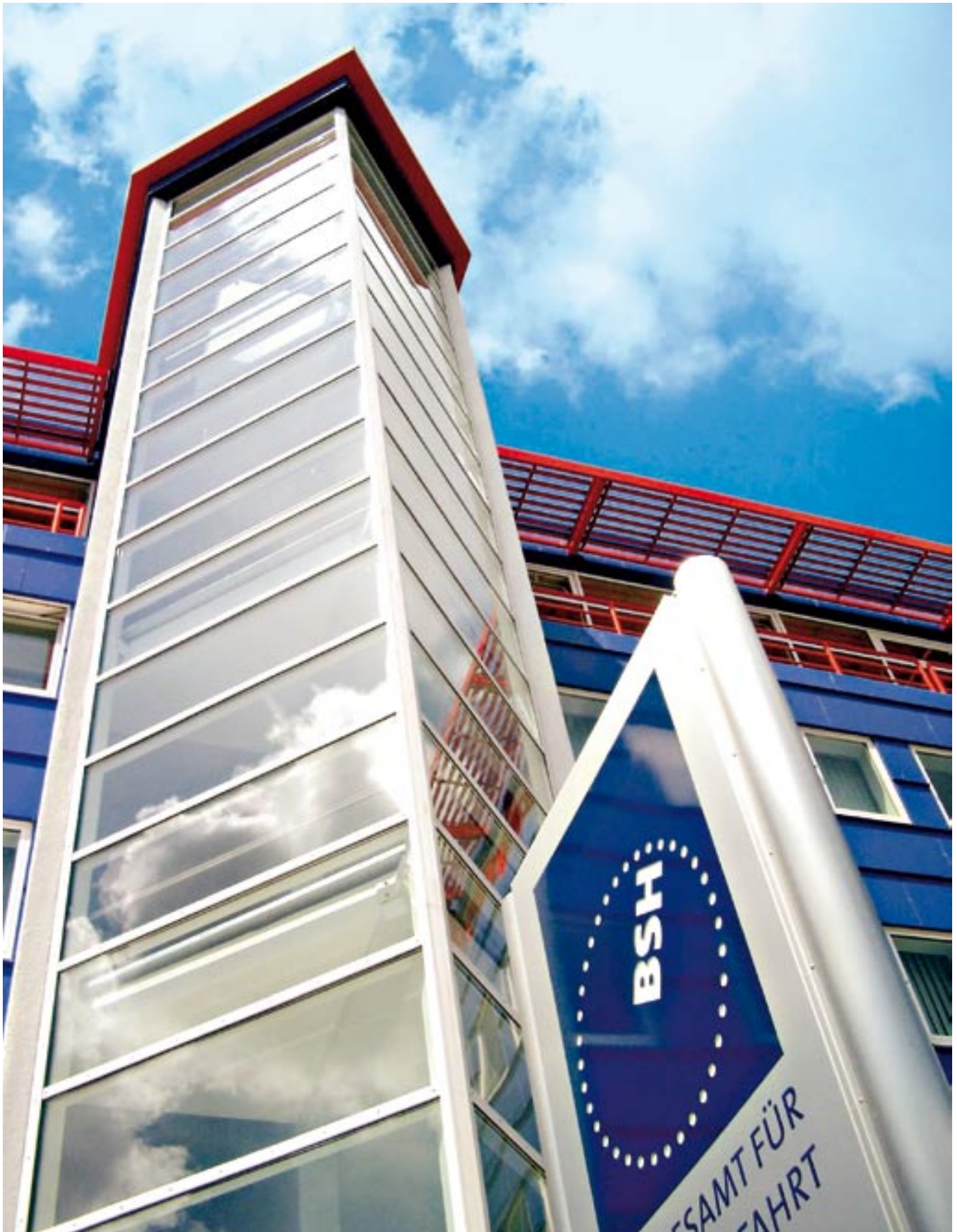
Ansicht Treppenhaus Büro-Neubau
