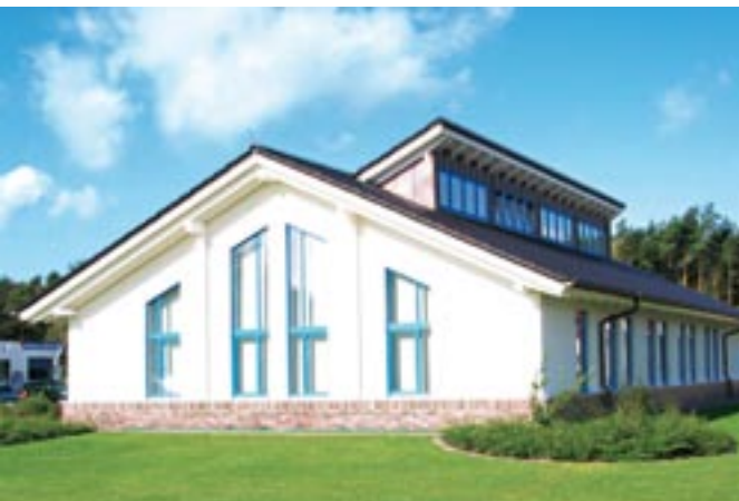
Bürogebäude Studtmann ( 2004), 27386 Hemsbünde, Außenwand: KS-Thermohaut Entwurf: Architekturbüro Röndigs, 27356 Rotenburg/Wümme
