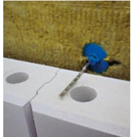
Rohbaudetail mit Dämmung und Befestigung des Verblendmauerwerks aus KS-Fasenstein
