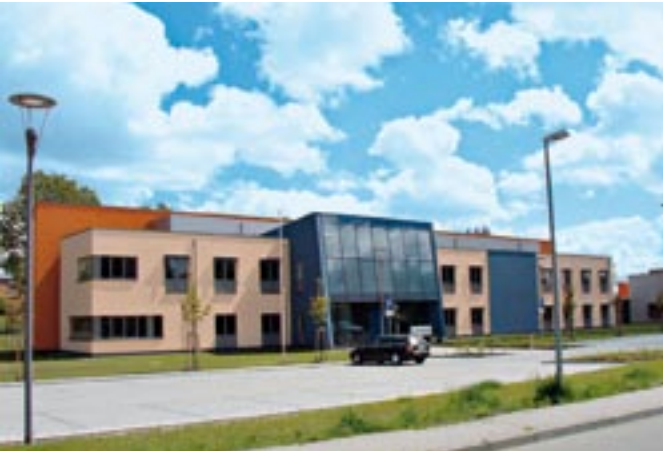
Kompetenz- und Gründerzentrum (2004), 18190 Groß Lüsewitz, Außenwand: KS-Thermohaut Entwurf: REKOPLAN NORD GMBH, 18059 Rostock, www.rekoplan-nord.de
