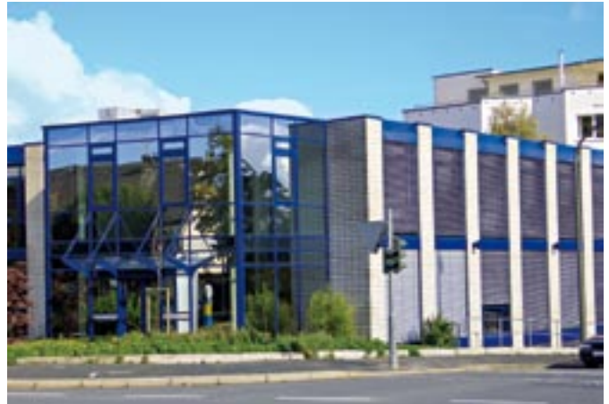
Bürogebäude (2001), 58097 Hagen, Außenwand: zweischaliges KS-Mauerwerk Entwurf: Planungsbüro Dipl.-Ing. Martin + Simon Müller, 79594 Inzlingen, www.idealbau-inzlingen.de
