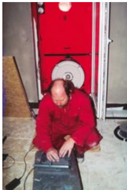
Bild 35: Mit dem Blower-Door-Test wird die Luftdichtigkeit geprüft.
