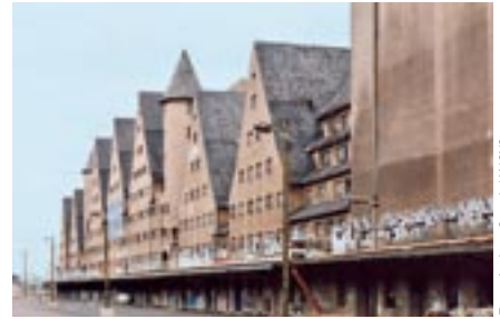
Ansicht Stadtseite vor der Sanierung
