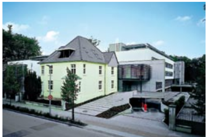
Bürozentrum als Passivhaus (2000), 33332 Gütersloh, Außenwand: KS-Thermohaut Entwurf: Architekten Hauer & Kortemeier, 33332 Gütersloh, www.hauer-und-kortemeier.de
