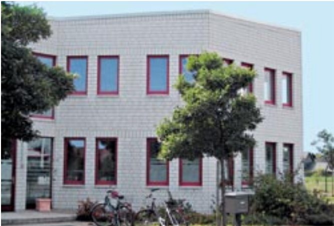
Bürogebäude mit Gewerbehalle (1999), 38543 Hillerse, Außenwand: zweischaliges KS-Mauerwerk, Entwurf: Jörn Dökel, 38543 Hillerse, www.ingdoekel.de
