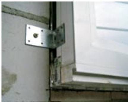
Fensteranschluss vor Anbringen des WDVS
