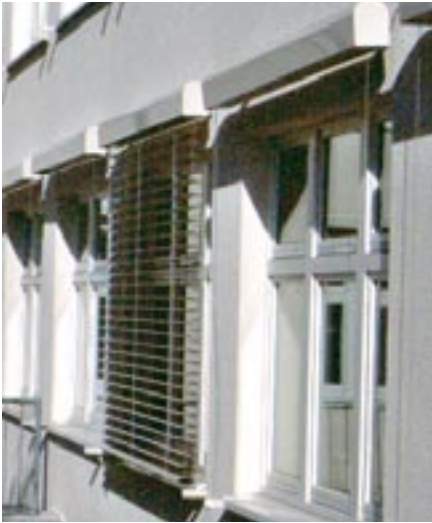
Bild 10: Beispiel für einen einfachen außen liegenden Sonnenschutz
