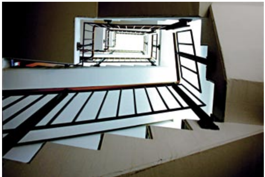
Erschließung durch das Treppenhaus
