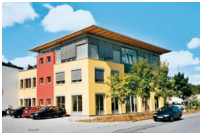
Verwaltungsgebäude Korbena Korkfabrik (2003), 92318 Neumarkt, Außenwand: KS-Thermohaut Entwurf: Kölbl Bau GmbH, 92318 Neumarkt/Opf., www.koelblbau.de
