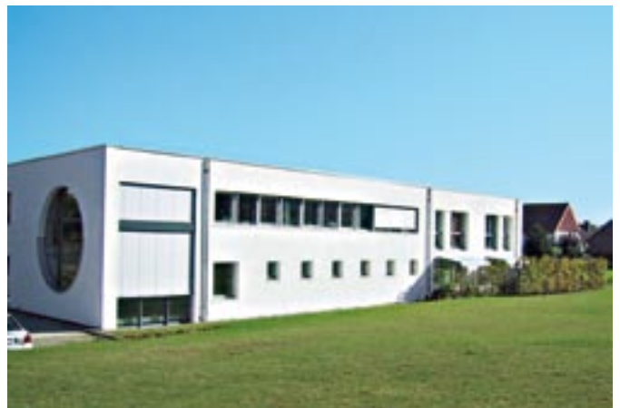
Bürogebäude als Passivhaus (2004), 38228 Salzgitter, Außenwand: KS-Thermohaut Entwurf: architecten gih – Guder – Jung – Hämmerli, 38228 Salzgitter
