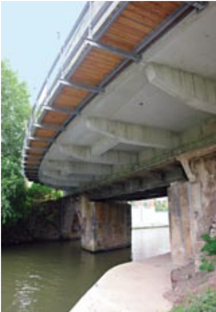
Bodenplatte auf zwei Stahlbetonträgern oberhalb der alten Brücke
