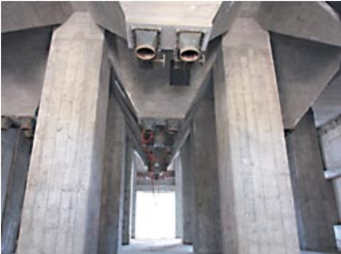
Erdgeschoss im „Silo“: Die Gestaltung bleibt für die Gastronomie erhalten.
