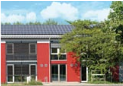
Photovoltaikanlage auf dem Seminargebäude
