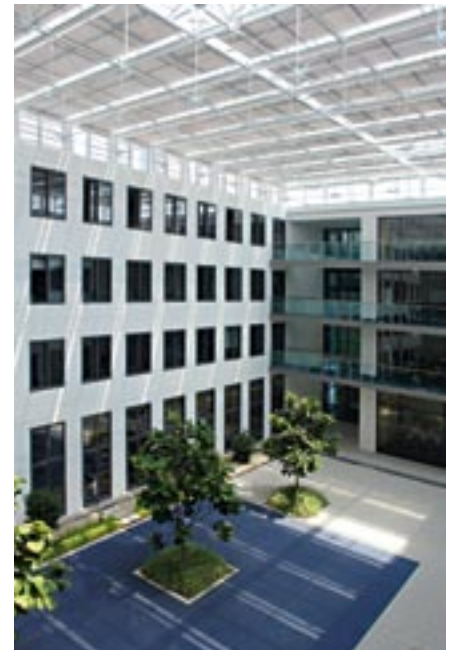
Innenhofsituation zwischen zwei Bürotrakten
