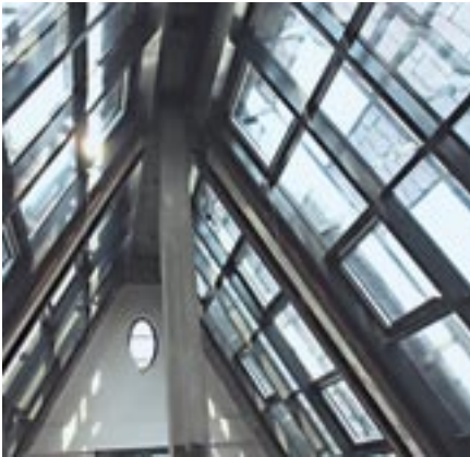
Dachverglasung mit Lamellen als partiellem Verschattungselement
