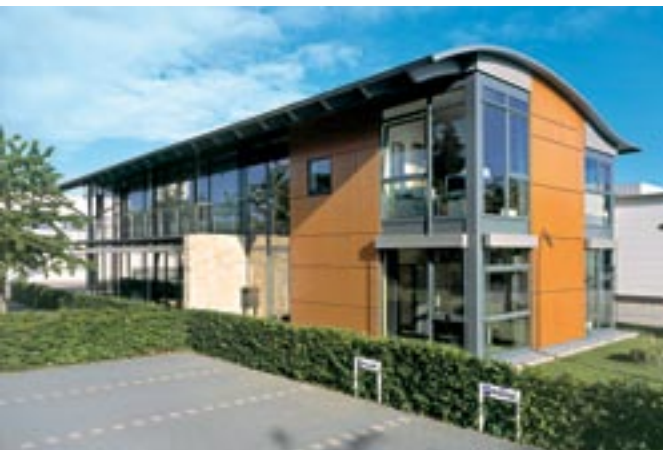
Bürogebäude mit Ausstellungsräumen der SOMAform GmbH (2000), 33428 Marienfeld, Außenwand: Kalksandstein mit Vorhangfassade Entwurf: Herzog & Kordtomeikel, 33330 Gütersloh, www.herzog-kordtomeikel.de
