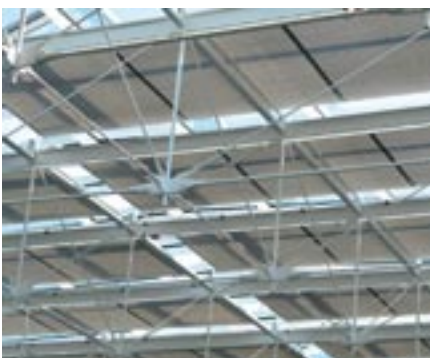
Dach des Innenhofbereichs
