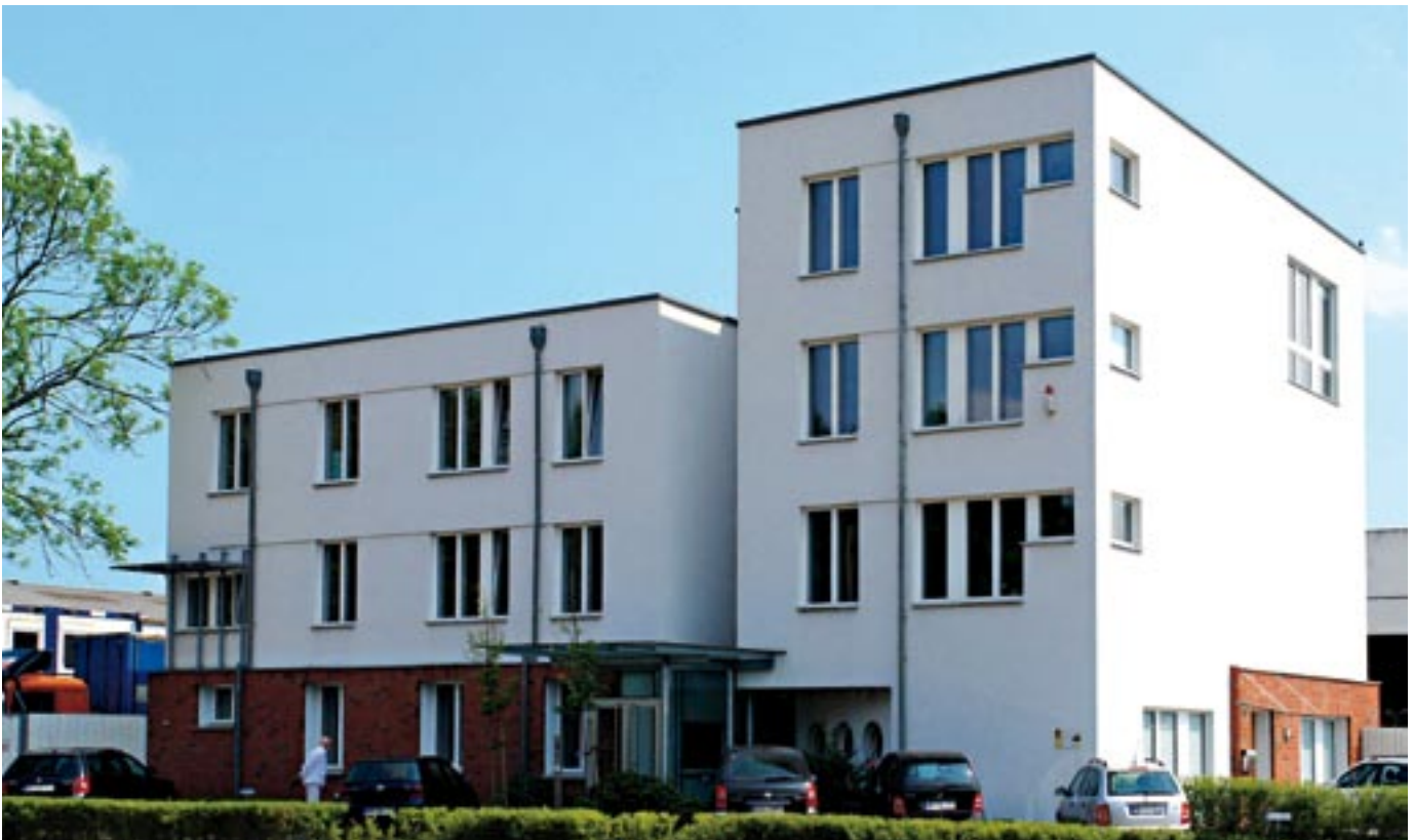
Ansicht von der Straßenseite: Bürogebäude im Passivhausstandard
