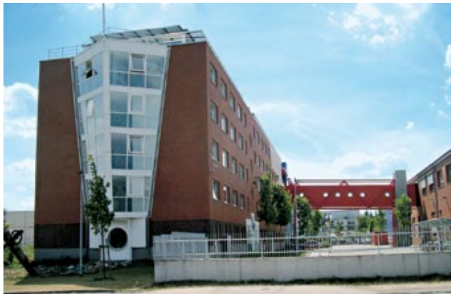
Ansicht Bug, hinten rechts der Querriegel zur Verbindung der beiden Gebäudeteile
