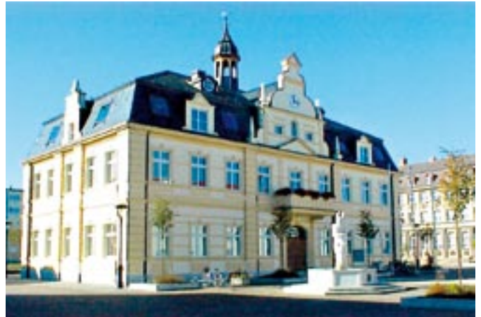
Rathaus Demmin (1998), 17109 Demmin, Außenwand: KS-Thermohaut Entwurf: S.M. zu Verl, Demmin
