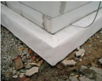
Wärmebrückenfreie Ausführung des Details Bodenplatte – aufgehende Wand
