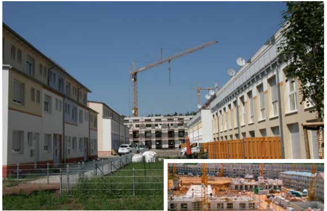
Fortsetzung von „Großbaustelle“
