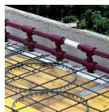
Deckenaufbau mit Schalung
