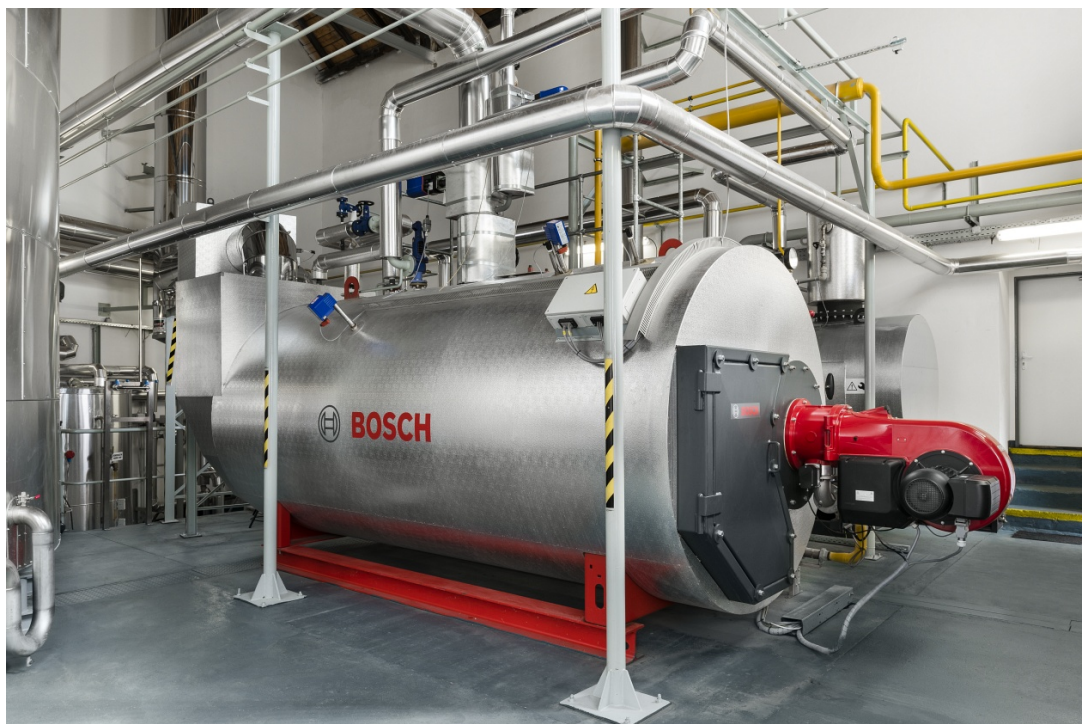
Abbildung 57: Moderner Dampferzeuger, Pivovar Klaster; Bildquelle: © Bosch Industriekessel GmbH
