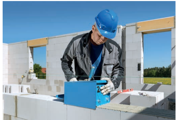
Bild 23 Aufziehen des Lagerfugenmörtels mit dem Mörtelschlitten
