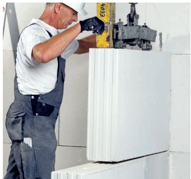
Bild 24 Vermauern von KS XL-Rasterelementen mit Versetzgerät
