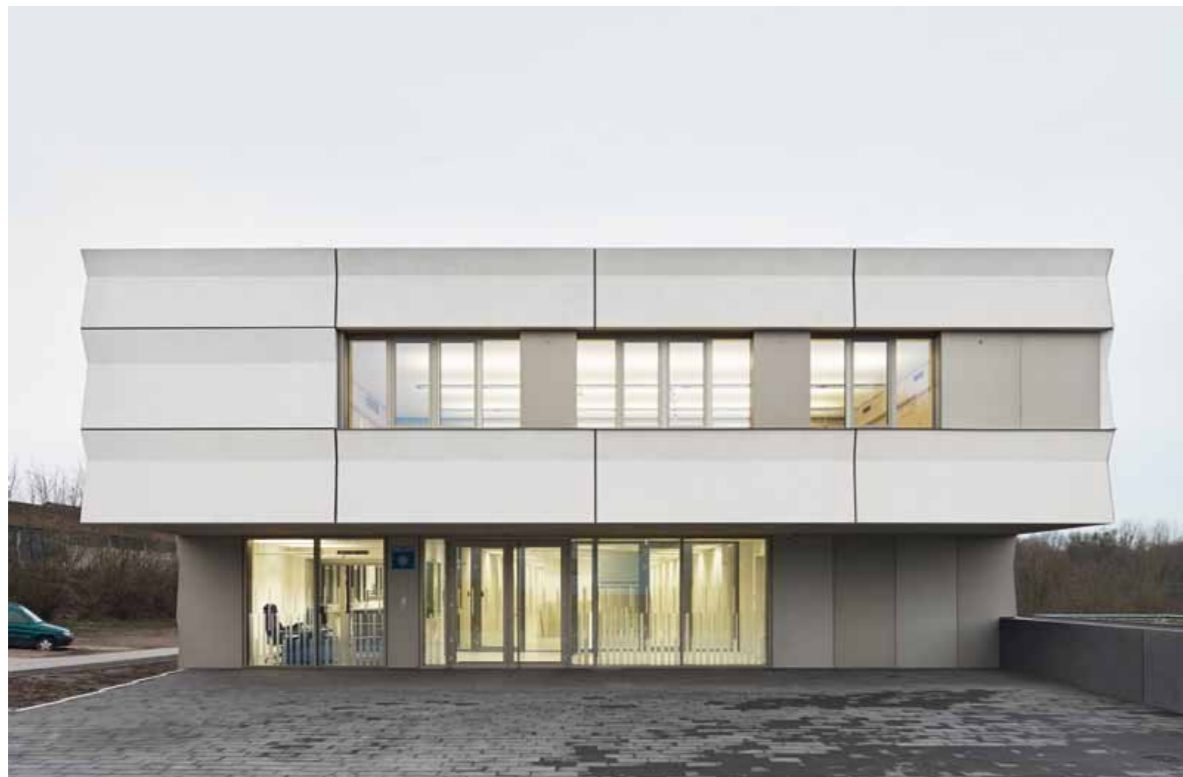
Das auskragende Obergeschoss schützt den Haupteingang vor Witterungseinflüssen.
