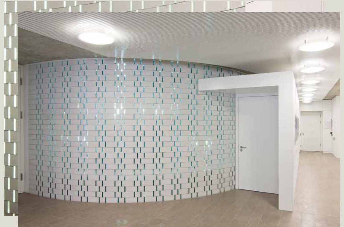
LRO Lederer Ragnarsdóttir Oei entwarfen das Haus der Kirche in Heilbronn. Im Erdgeschoss befindet sich ein aus Kalksandstein gestalteter Andachtsraum, der sogenannte Raum der Stille.
